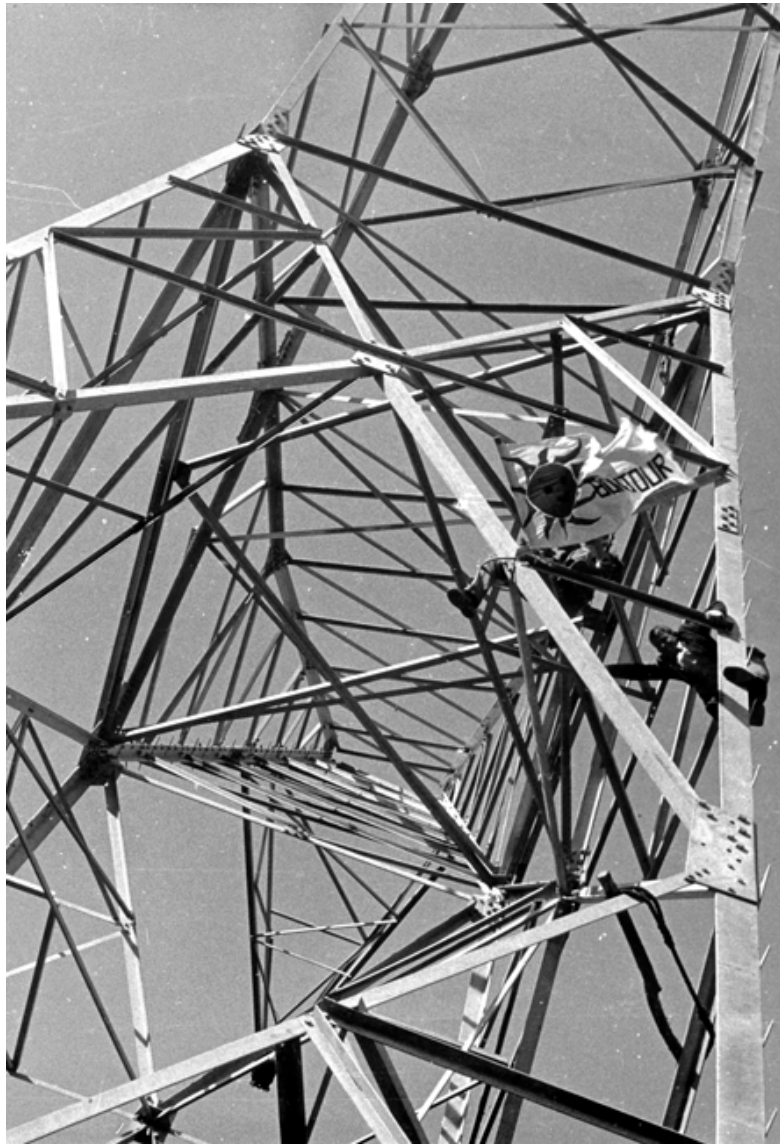
Abbildung 2: Radio Verte Fessenheim sendet aus dem Elsass vom Mast einer französischen Elektrizitätsgesellschaft, © RDL-Archiv
